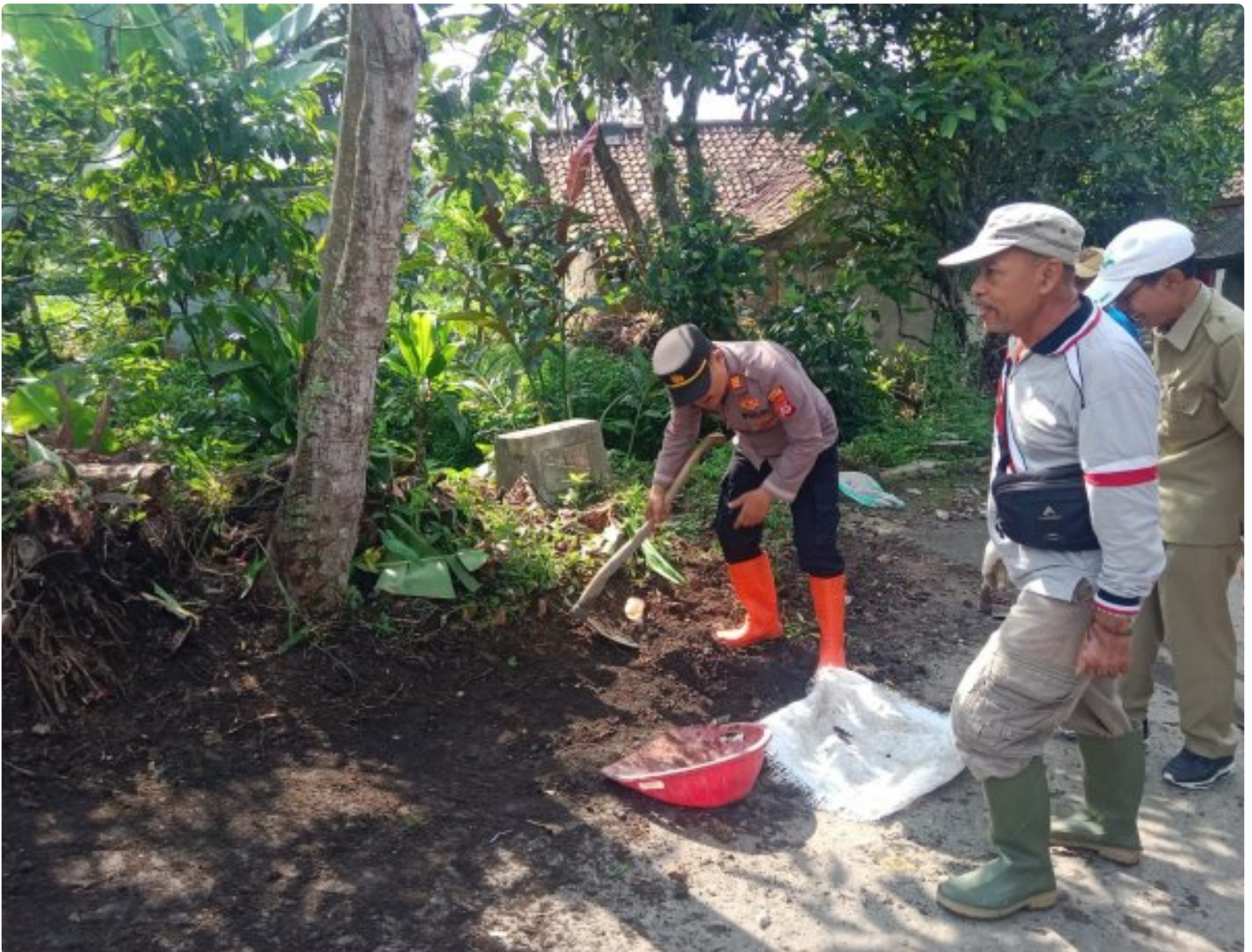
Kapolsek AKP A. Suryana Gotongroyong Bersama Warga Kompak Perbaiki Jalan Rusak serta Bersihkan Lingkungan
