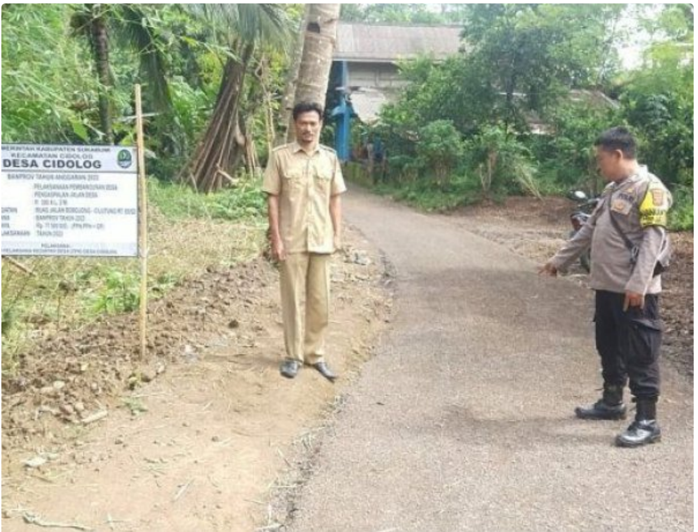
Bhabinkamtibmas Desa Cidolog Awasi Pembangunan Desa
