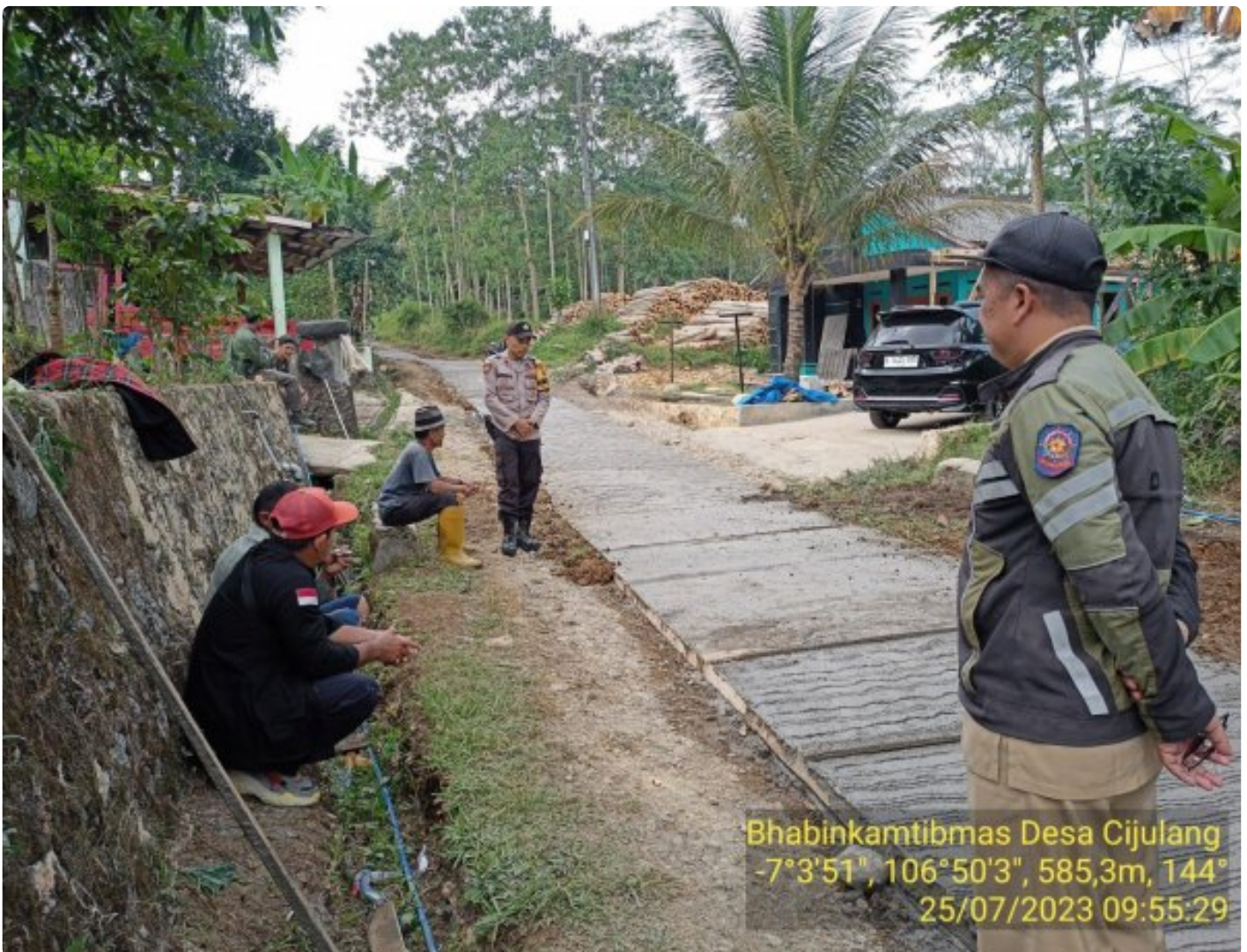
Aipda Sudiro Monitoring Pembangunan MCK di Desa
